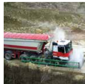
Sistema automatico di lavaggio degli pneumatici dei mezzi pesanti in uscita dall'area di cantiere
