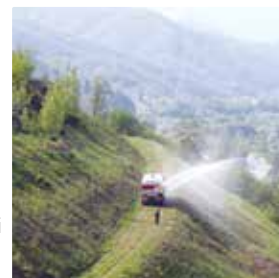
Gettito d'acqua per rivegetazione erbacea eseguita attraverso idrosemina
